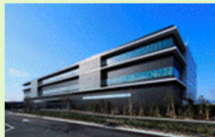
トヨタ自動車九州テクノセンター (2016年3月開設)
